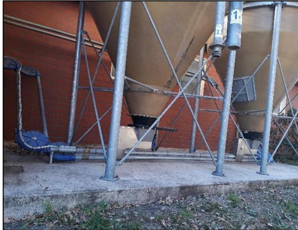
*Silos mit VoluMeter: Unter jedem der beiden Futtersilos sitzt die Dosierautomatik, die für das richtige Mischungsverhältnis bei der Multiphasenfütterung sorgt.*
