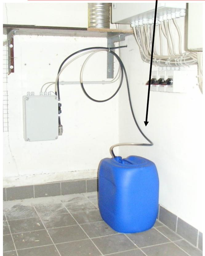
Zusatzprodukt wird über eine Einsprühdüse in die Fütterungsanlage eindosiert
