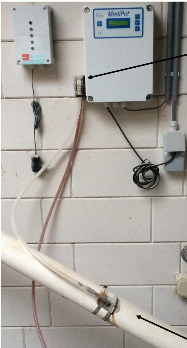
Dosierpumpe pumpt Zusatzstoff aus Produktbehälter in die Saugleitung
